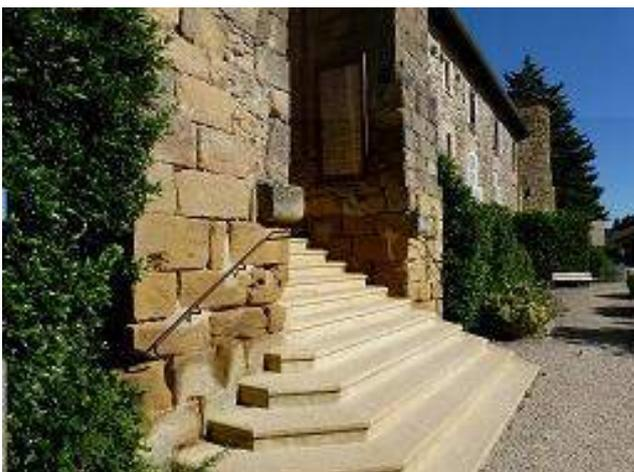
Pierres altérées par le sel de la montée au château
